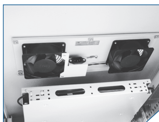
Установка вентиляторных модулей серии МВ-400-2
